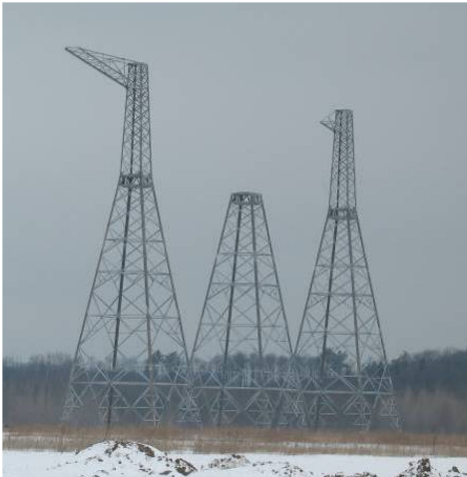
Малюнок 6.1 Типова анкерно-кутова опора УС 750-1 (750 кВ)
