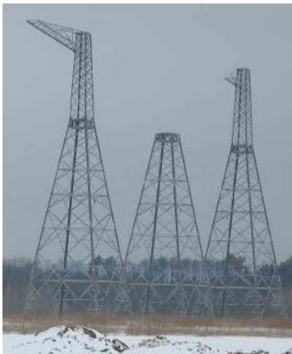
Малюнок 1.4 Фотографії анкерно-кутової та проміжної опор
