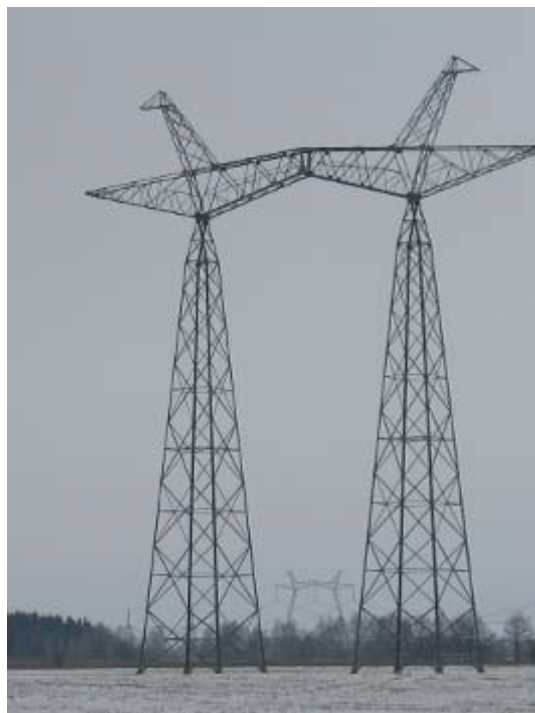
Малюнок 1.4 Фотографії анкерно-кутової та проміжної опор
