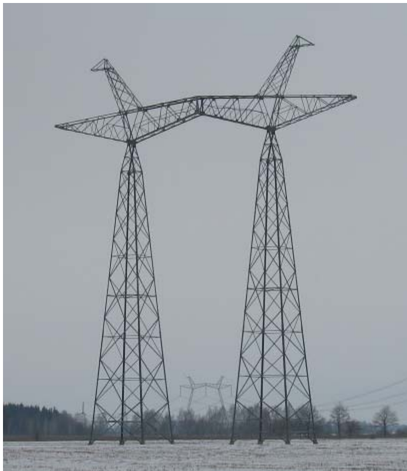
Малюнок 6.2 Типова проміжна опора ПС 750-3 (750 кВ)
